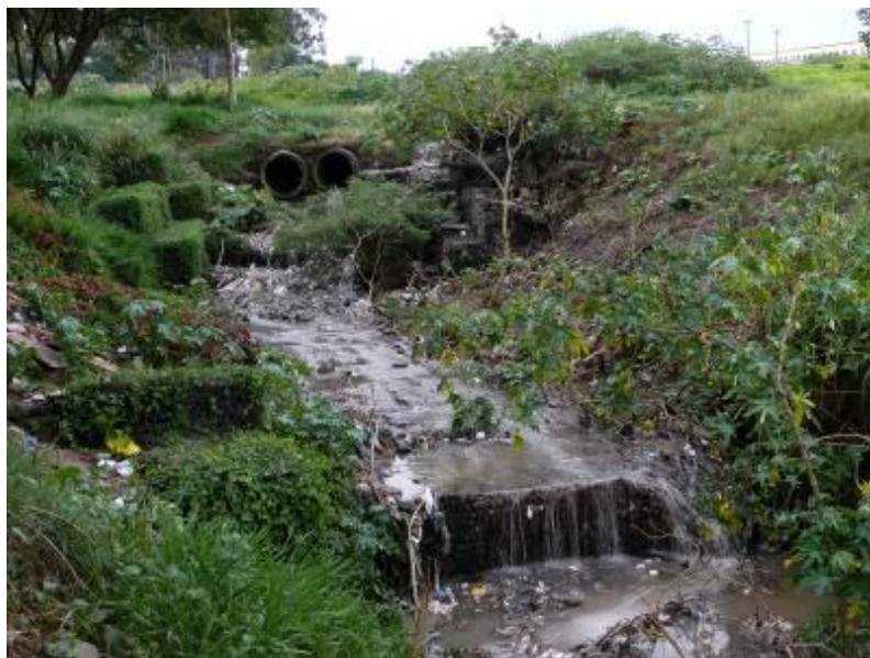
Imagem 28 - A nascente do Ribeirão Jacuba, até o ano de 2010 recebia efluentes do Complexo Penitenciário em estado bruto e não conta com vegetação ciliar.
